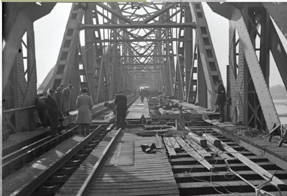
Foto: Vervanging middelste overspanning van de spoorbrug in 1950
